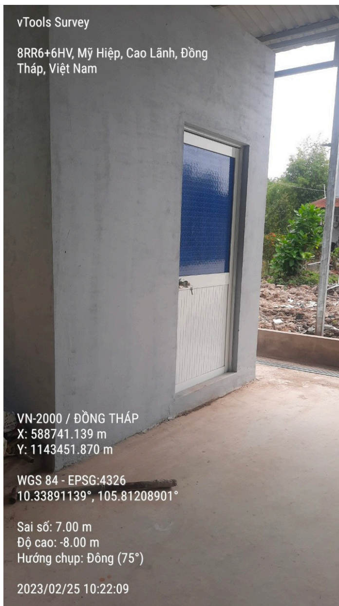
Hình 10. Nhà vệ sinh tại dự án
